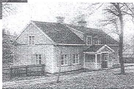
Den gamla flygelbyggnaden, tidigare mangårdsbyggnad under många år, revs i mitten på 1980-talet
